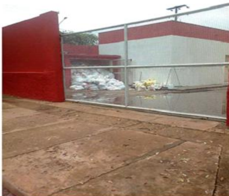
Figura 13: Armazenamento temporário dos RSSS em uma Instituição de Saúde Pública de Rondonópolis-MT, 2011 – Visão externa do local
