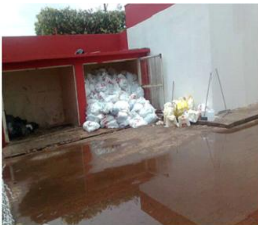
Figura 14: Armazenamento temporário dos RSSS em uma Instituição de Saúde Pública de Rondonópolis-MT, 2011 – Visão Interna do local
